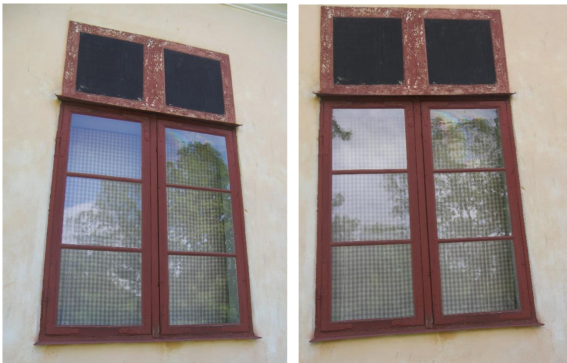
Exempel på övre blindfönster. T.v. B3 och t.h. D1.
